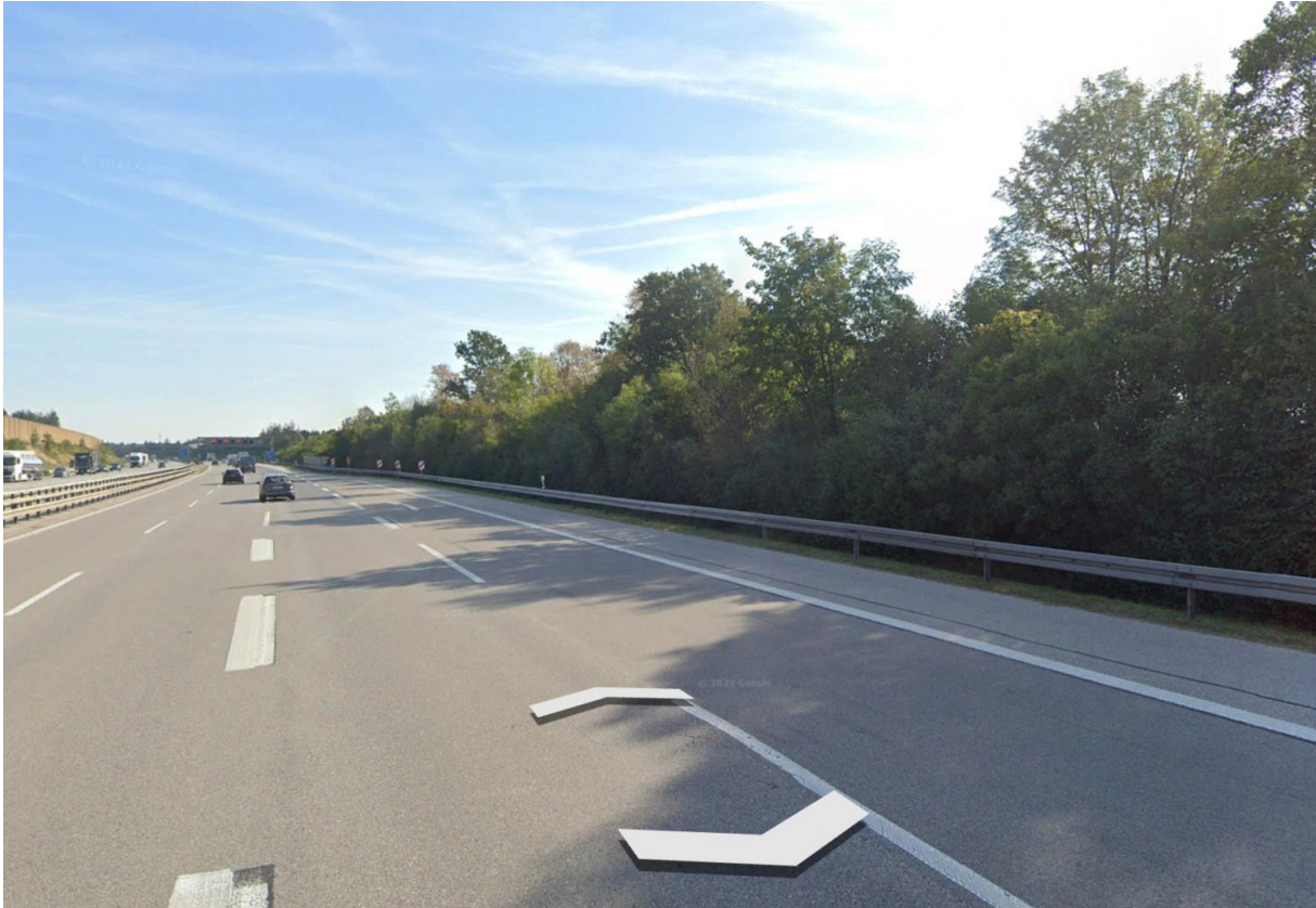
Abbildung 18: Vegetationsstreifen zwischen PVA und Autobahn – Quelle Abbildung: Google Earth Pro
